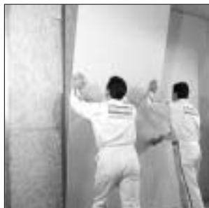
Oblaganje kovinske podkonstrukcije
