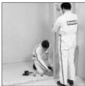
Montaža lesenih nosilcev z žebli ali kovinskimi kotniki
