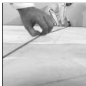
Označevanje stenske osi s svinčnico ali gradbenim laserjem
