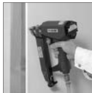
Pritrjevanje s spojkami na leseno podkonstrukcijo
