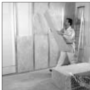
Nameščanje izolacijskih plošč
