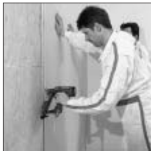
Oblaganje lesene podkonstrukcije s sponkanjem.
