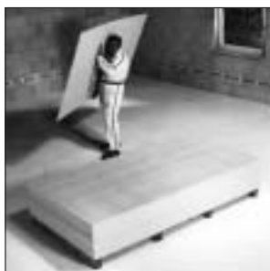
Nosite posamezne montažne plošče pokonci
