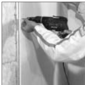
Nameščanje vrtalnika za hitro privijanje
