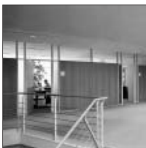
Stena hodnika s ploščami NFO, furnirana z naravnim furnirjem, in z dvojno zastekljeno nadsvetlobo.
