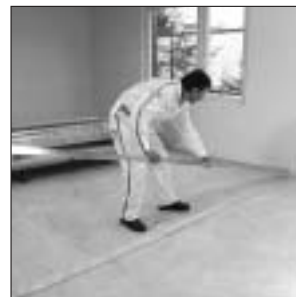
olaganje priključnih UW-profilov na tleh na izolacijske trakove
