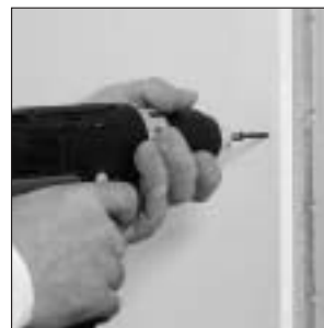
Privijanje na kovinsko podkonstrukcijo
