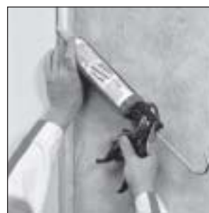
Vodenje 310 ml kartuše ob robu plošče
